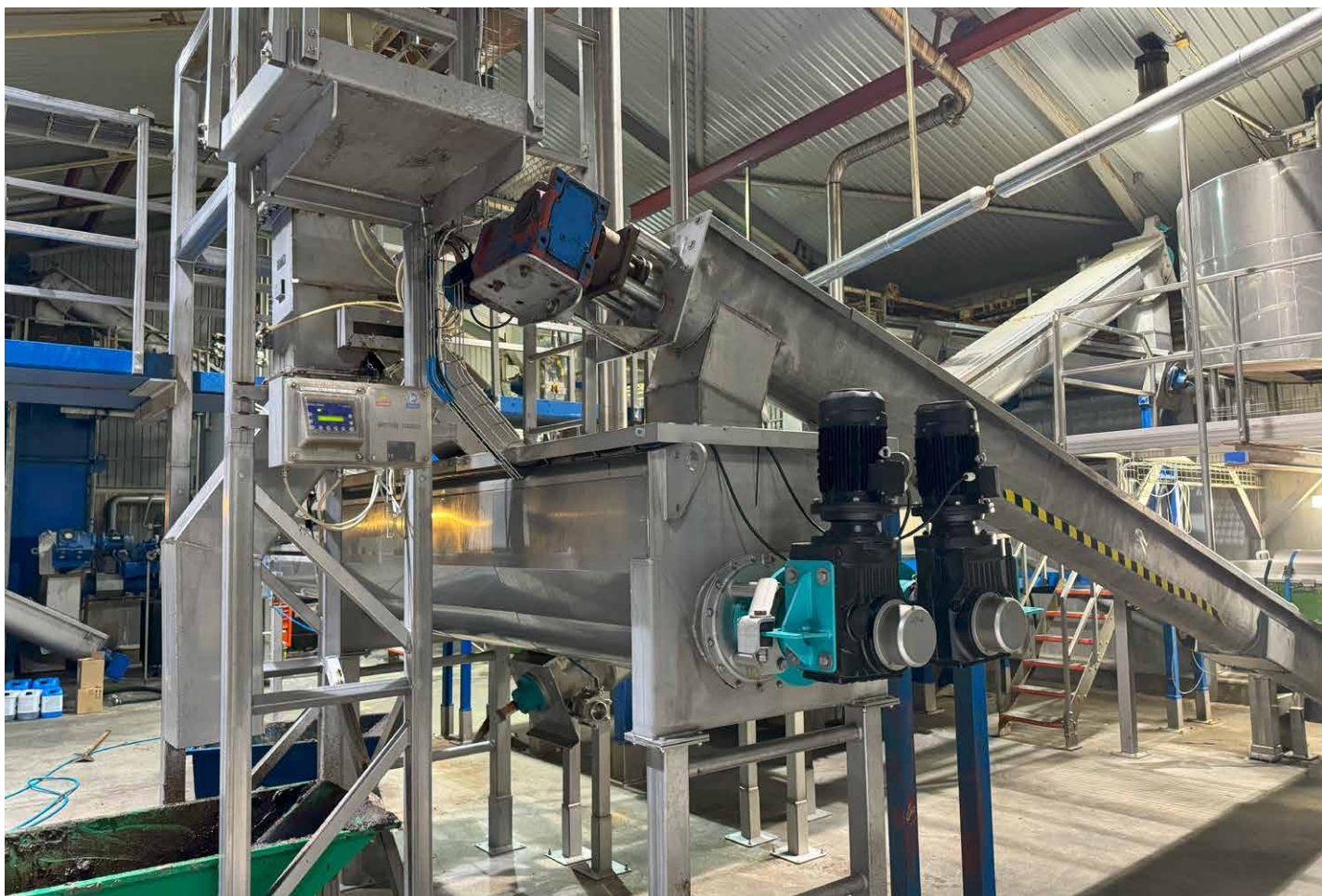
Ny utslagskasse i Balsfjord.
