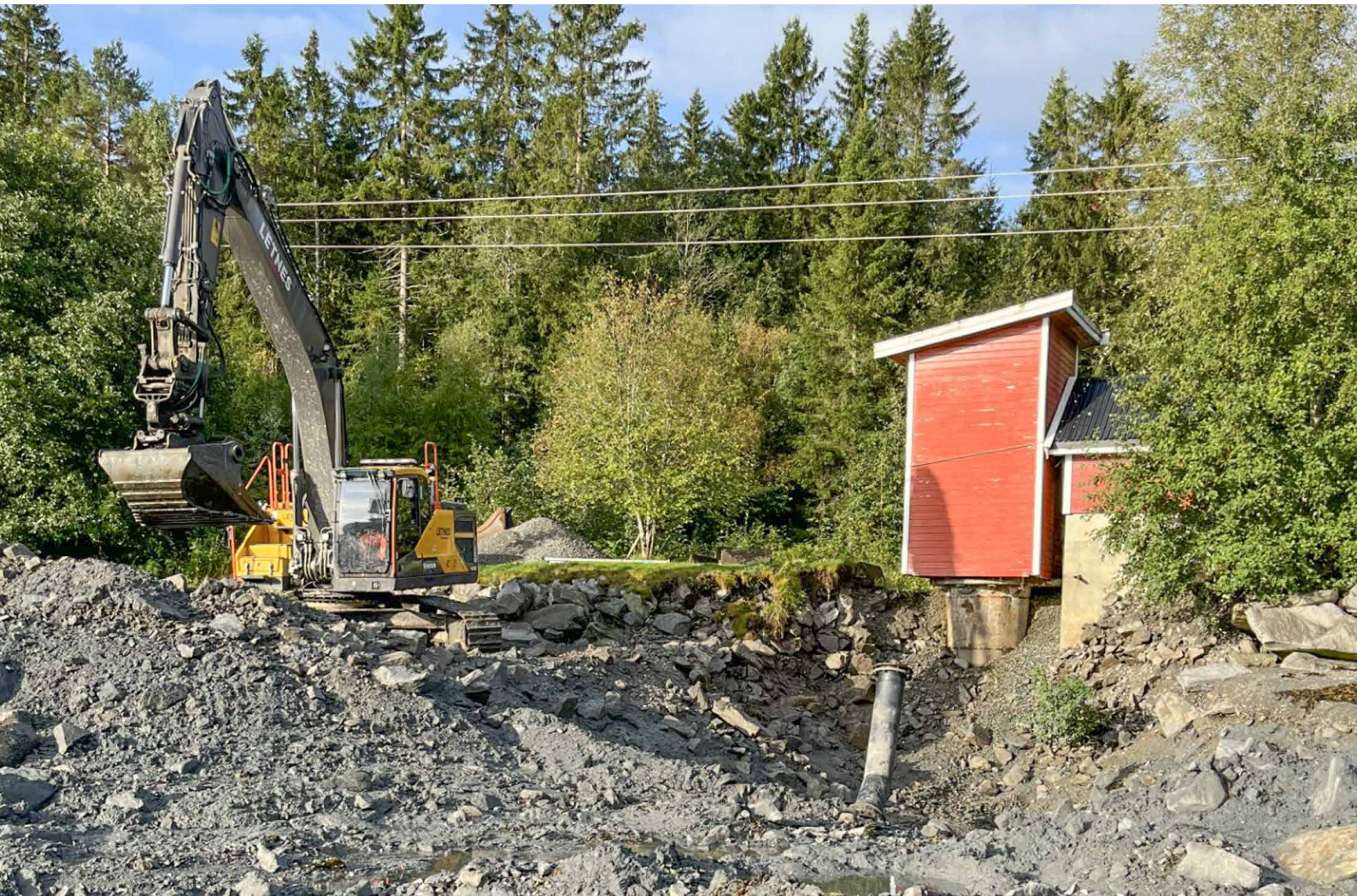
Reparasjon av sjøvannsledning i Mosvik
