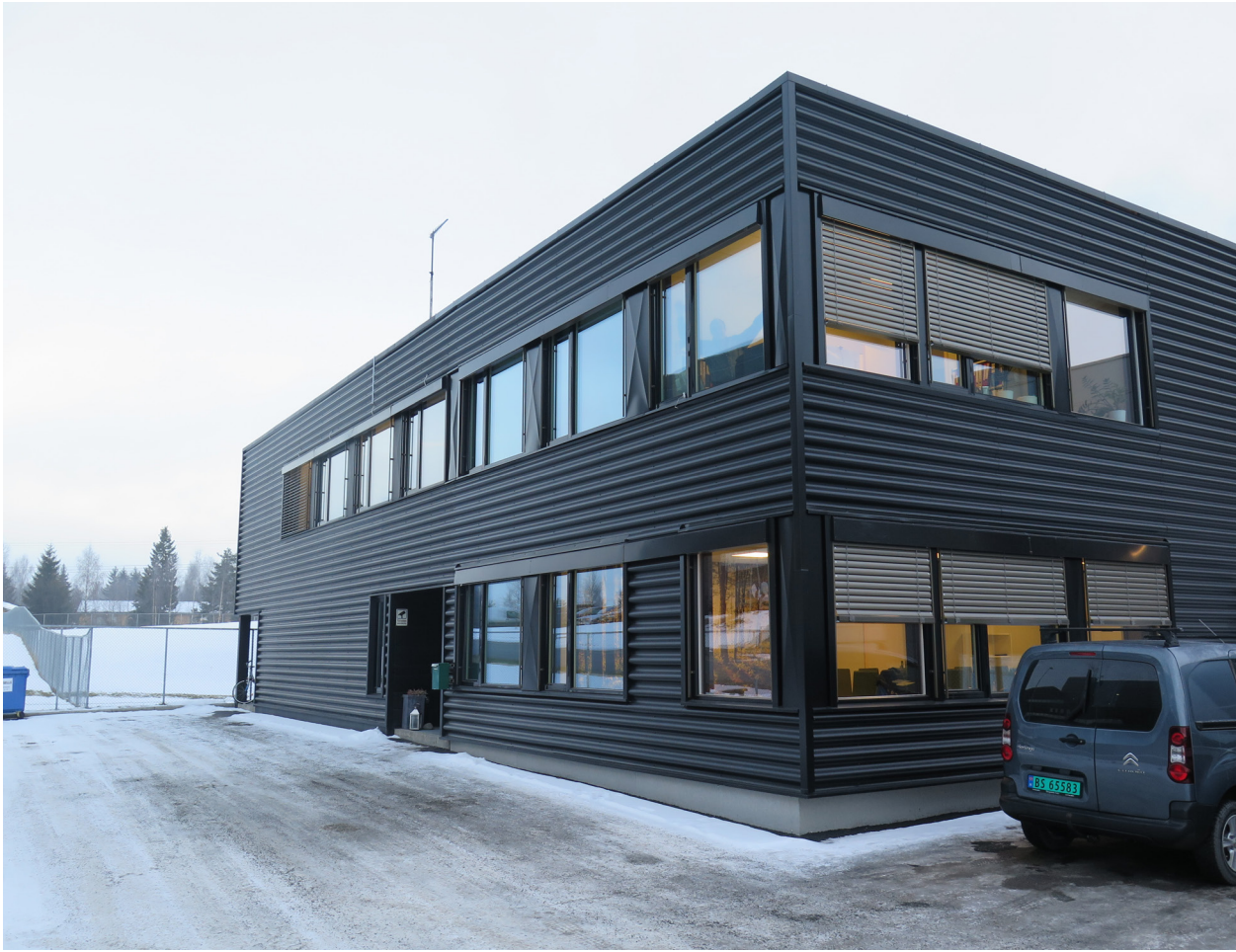
Utvidet kontorbygg på Hamar
